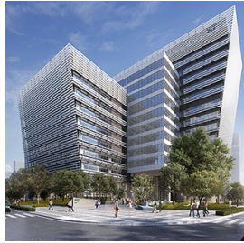
コンクリート構造物
